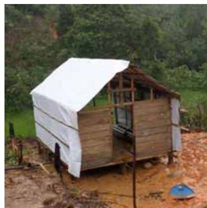
Maison en cours de reconstruction
