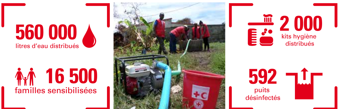
Réhabilitation d'un puits dans la région d'Antalaha
