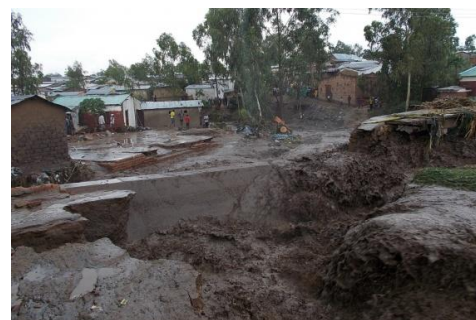
Voies d'accès endommagées
